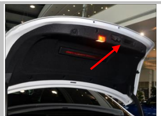
4.3 安装开关按钮：在原车此处装上开关按钮；
